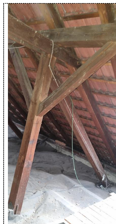
Obr. 5 Křeštiny, pásky, vaznice, sloupy a vzpěry [P1]
