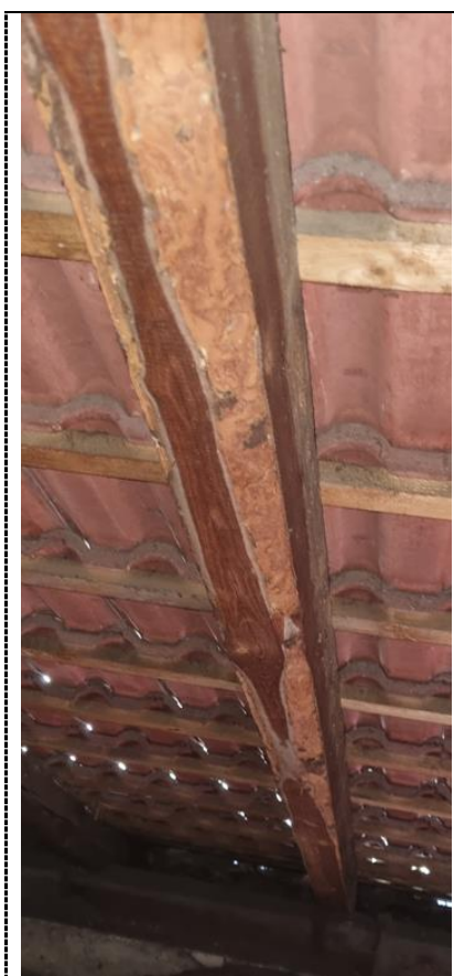
Obr. 8 Viditelně poškozená krokev biotickými škůdci [P1]
