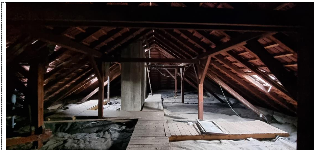
Obr. 4 Půdní prostor, pohledy na plné a jalové vazby [P1]
