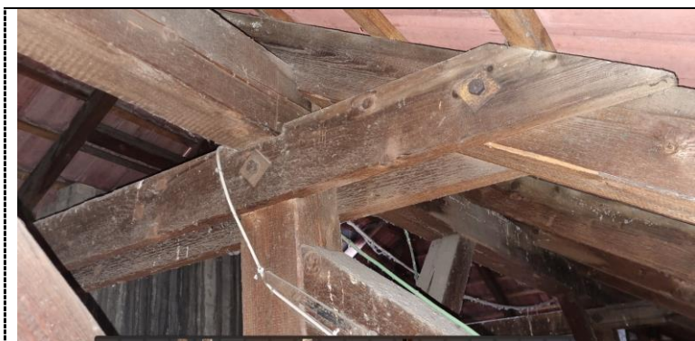
Obr. 8 Viditelně poškozená krokev biotickými škůdci [P1]
