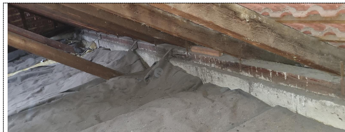
Obr. 5 Křeštiny, pásky, vaznice, sloupy a vzpěry [P1]
